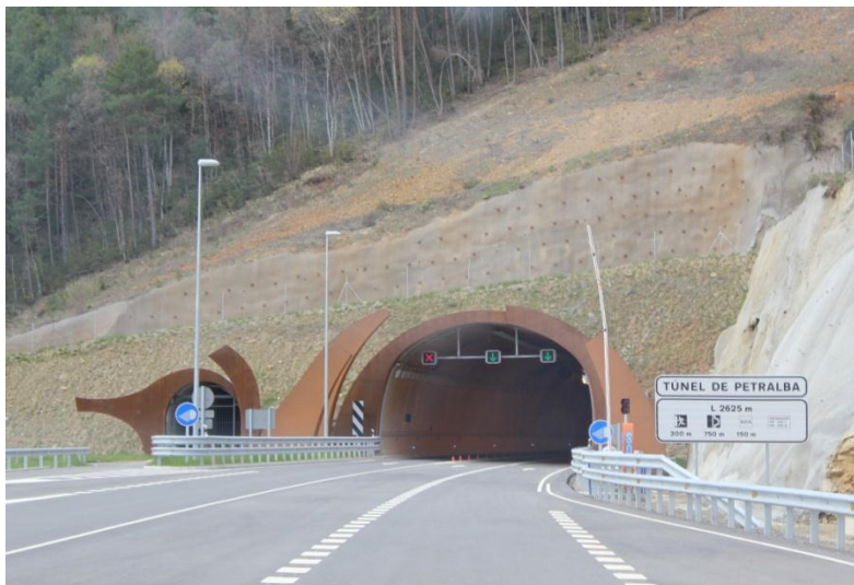
L'entrée du tunnel de Petralba, à l'est. (Photo JMG)
