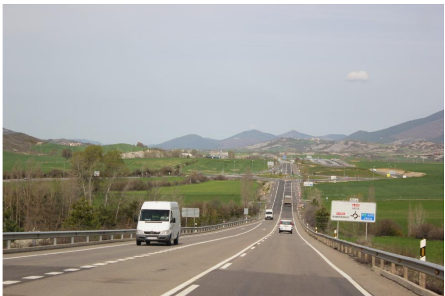
La nouvelle route de Fiscal est connectée à l'A23 à Sabiñanigo
