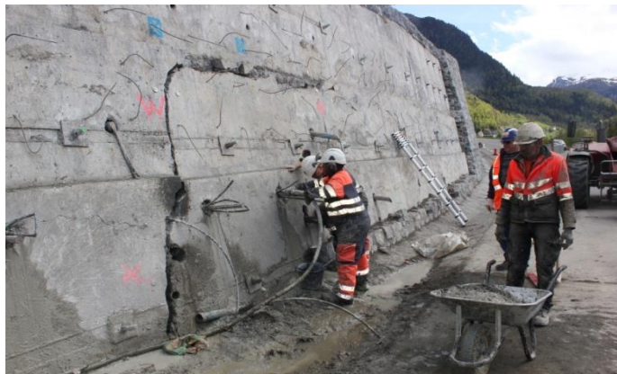
Les ouvriers ont commencé à renforcer par des pieux horizontaux le mur de soutènement profondément fissuré (photo BAP)
