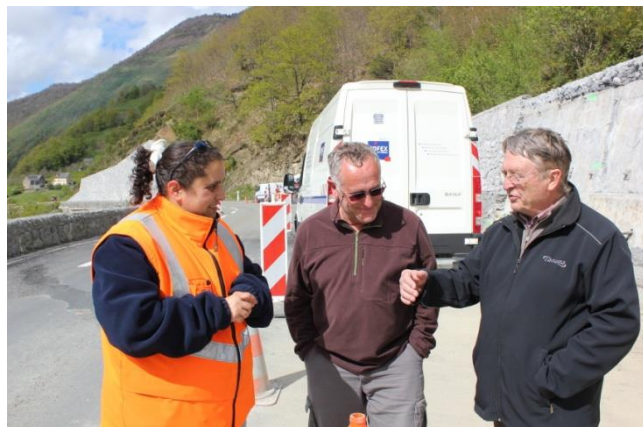
Christelle Dulout (DIRA), Jacques Marquèze - au centre - et Gabriel Loudet (commission routes de BAP) évoquent les problèmes créés par l'affaissement (photo BAP)
